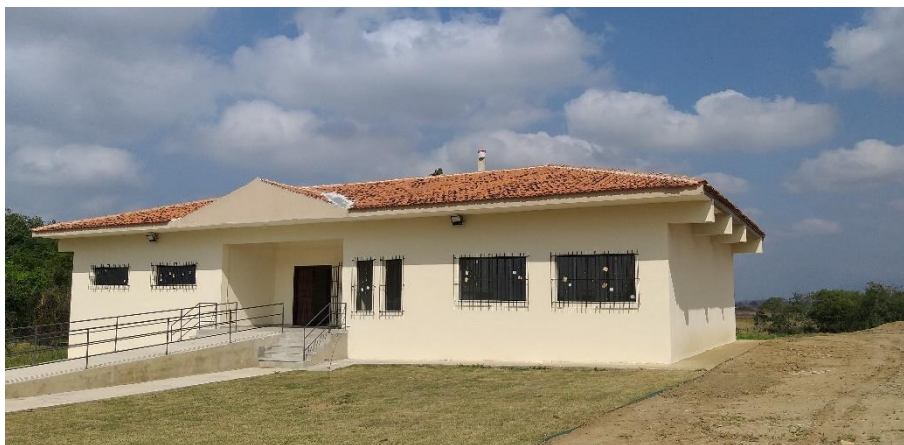
Figuras 15 e 16: Rampa de acesso ao prédio da Geodésia
