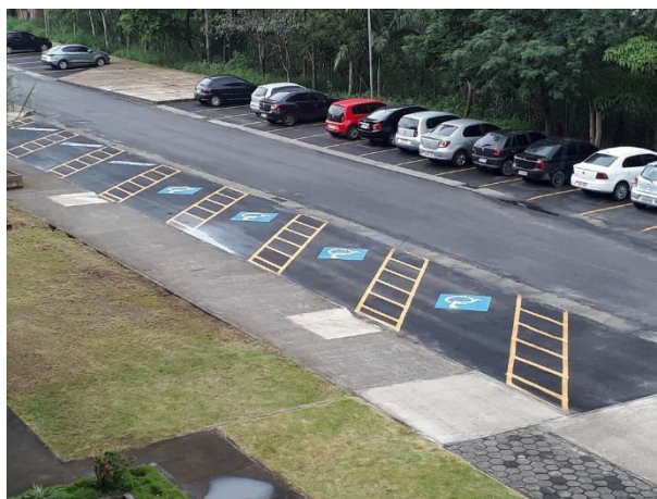
Figura 24: Estacionamento com vagas reservadas à pessoas com deficiência no pátio do IM. Destaque para sinalização horizontal e falta de sinalização vertical
