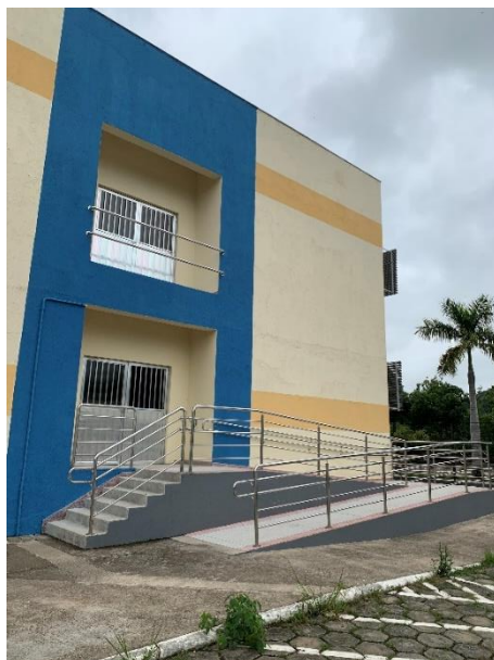
Figura 25: Nova rampa de acesso a setor de atendimento direto ao público (Núcleo de Prática Jurídica) no prédio do ITR, em projeto de reforma recém executado.
