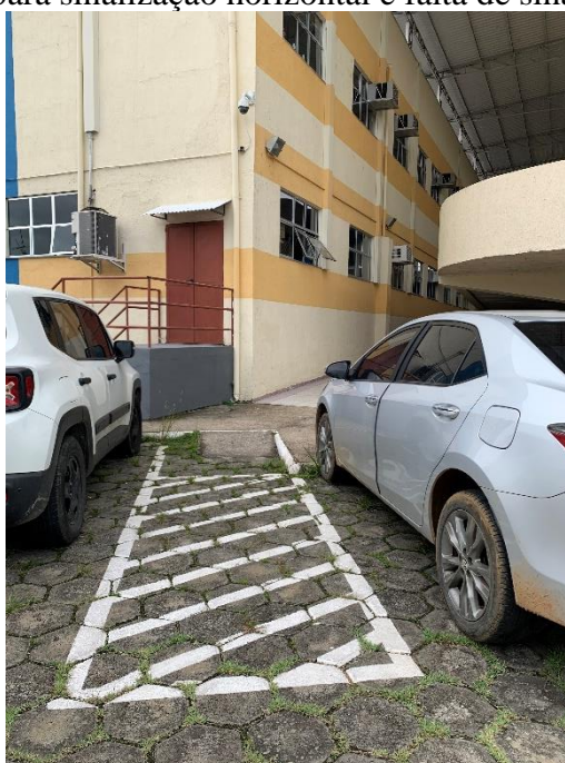
Figura 25: Estacionamento do ITR com sinalização horizontal parcial, demarcando o espaço adicional de circulação entre vagas reservadas, e ausência de pintura demarcando a vaga e sinalização vertical
