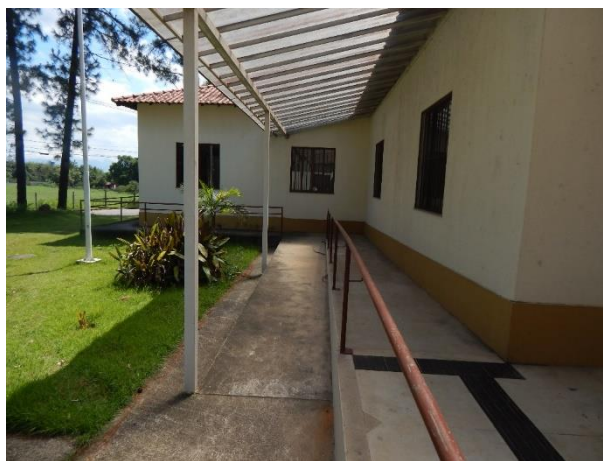
Figura 14: Rampa de acesso ao prédio da Biodiversidade
