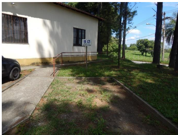
Figura 28: Vaga reservada no prédio da Biodiversidade. Sinalização vertical presente e sinalização horizontal deficitária.
