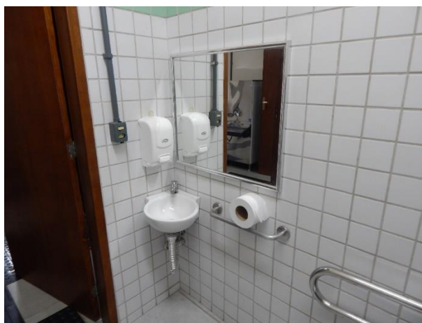
Figura 40: Banheiro Acessível - Prédio da Biodiversidade
