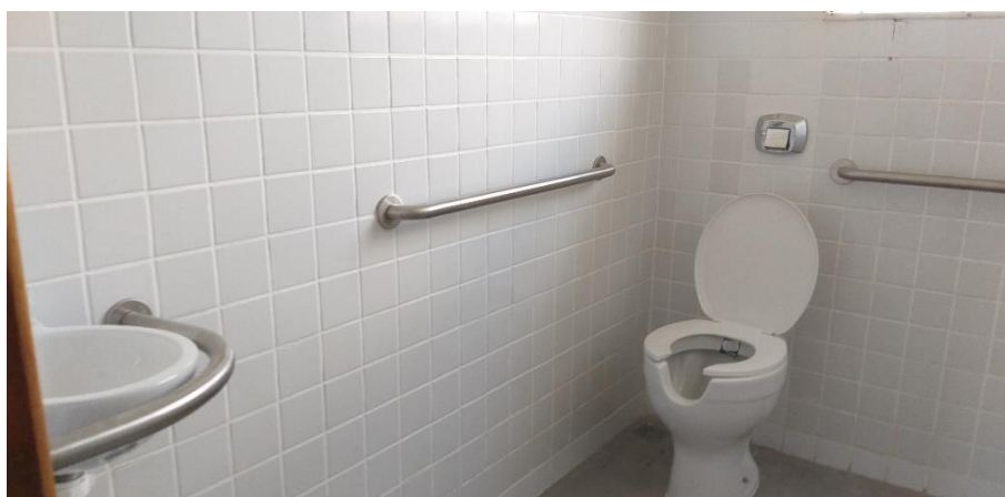
Figura 41: Banheiro Acessível - Prédio da Geodésia
