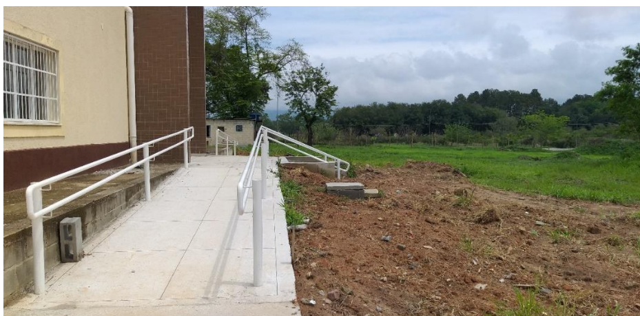
Figura 24: Rampa de acesso no prédio do PAP-Física, recém-concluída
