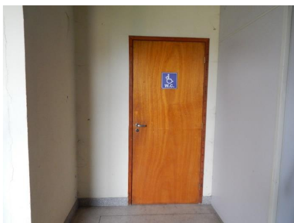
Figura 34: Sinalização de Banheiro Acessível - Biblioteca Central
