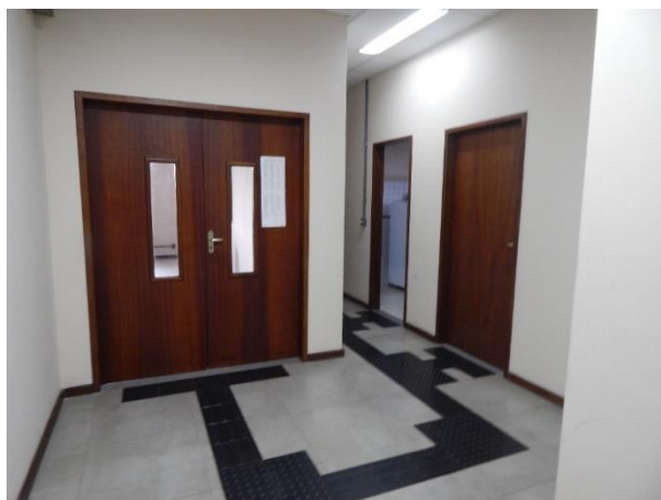
Figuras 55, 56, 57 e 58: Sinalização tátil no piso em circulação externa e interna do Prédio da Biodiversidade
