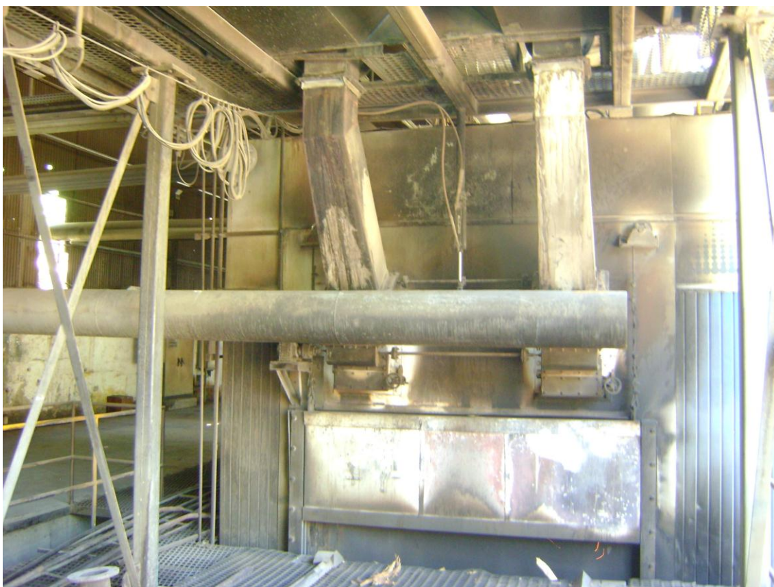
Figura 32: Caldeira a lenha da Q.V., Barra do Pirai/RJ
