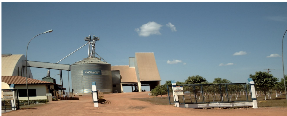
Foto V- Armazém da Bunge no município de Querência
