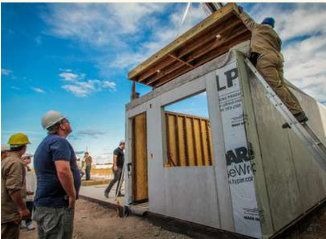
Imagem do processo de uma construção em Wood Frame Fonte: Divulgação NoAr Assessoria & Comunicação
