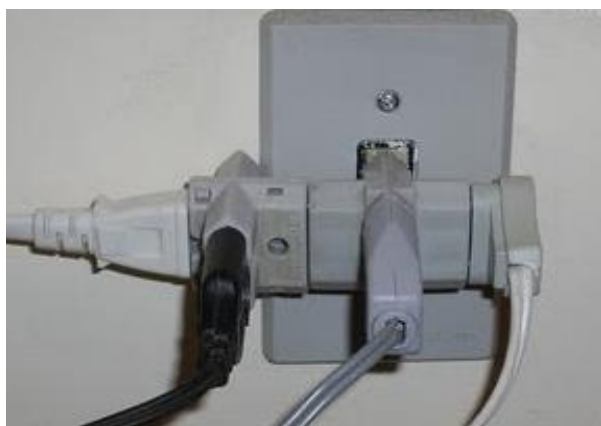
Figura 13 -Tomada sobrecarregada.
