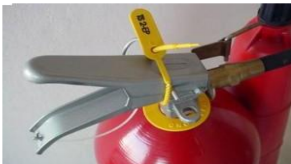
Figura – 16 Anel indica que extintor passou pela recarga (em 2019).
