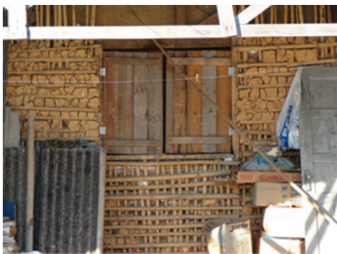
Foto 9 Casa de pau a pique, Terra Livre - Resende [RJ], 2006. [doc.fot.]. Foto Thiago Ferreira.
