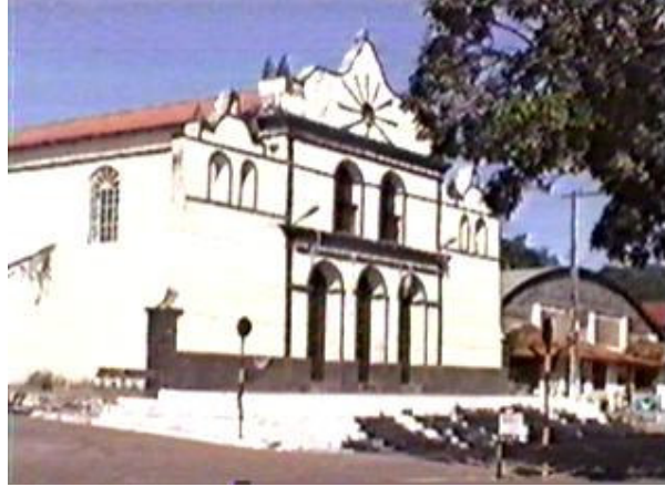
FIGURA 08: Igreja Nossa Senhora da Saúde, Vila de Alter do Chão
