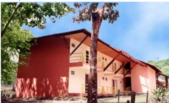
FIGURA 22: Blocos de Apartamentos do Belo Alter, Hotel da Vila de Alter do Chão.
